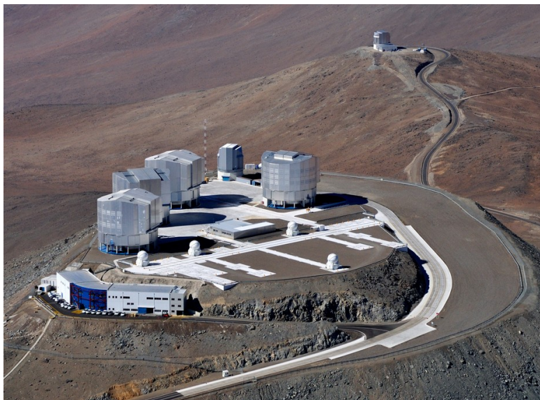
Рис. 4. Обсерватория на г. Паранал (Чили). 4 телескопа VLT с диаметром зеркал 8.2 м. Перед ними 4 1.8-м телескопа поддержки, способные перемещаться по площадке на рельсах и обеспечивать оптические интерференционные наблюдения с базой до 200 м.
